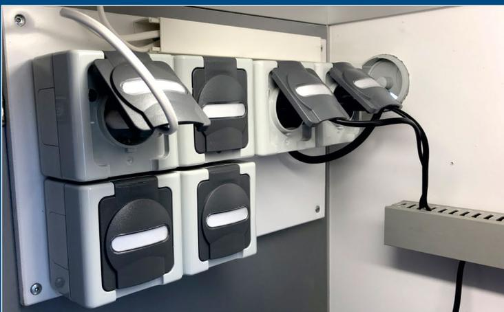
EFS Marine -Line Detail / 6 Feuchtraumsteckdosen und Kabelkanal für Ordnung und Sauberkeit
